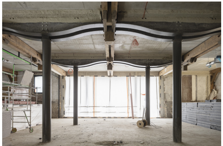
Le lobby et sa nouvelle charpente métallique avec les poutres bois existantes
