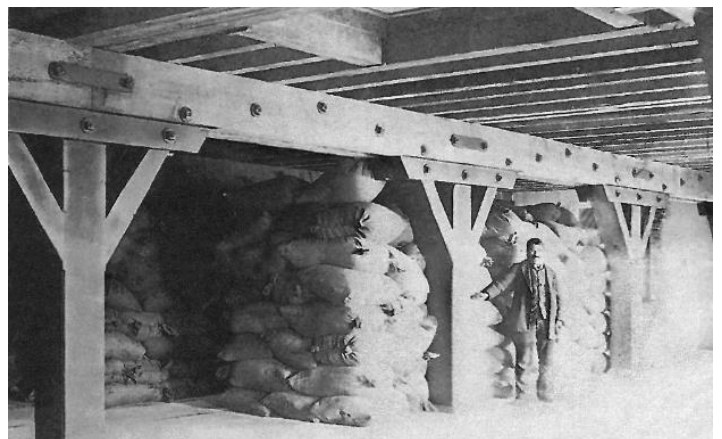
Un entrepôt à grains composé de sa structure bois. Source : Ibid.
