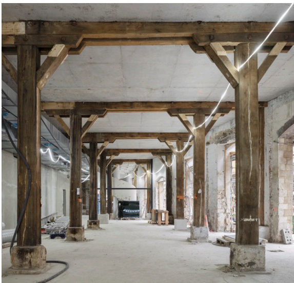
Pendant les travaux
